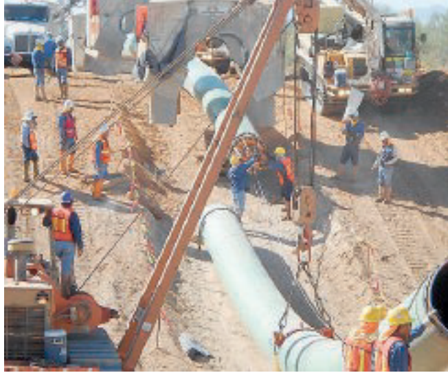
SICIM Un cantiere del gruppo.
