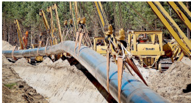
PIPELINE Un cantiere della Bonatti.
