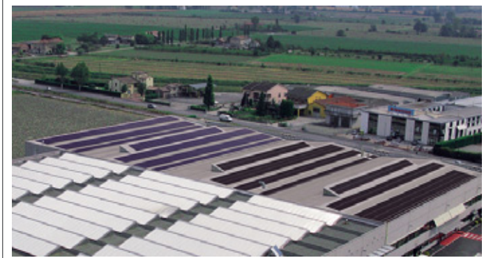
Lentigione il tetto fotovoltaico sullo stabilimento n° 2 Immergas.
