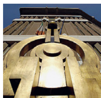
Cciao La sede di via Verdi.
