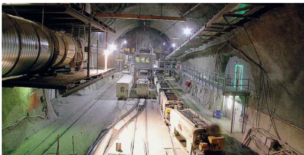
Pizzarotti Il cantiere nella galleria San Gottardo.
